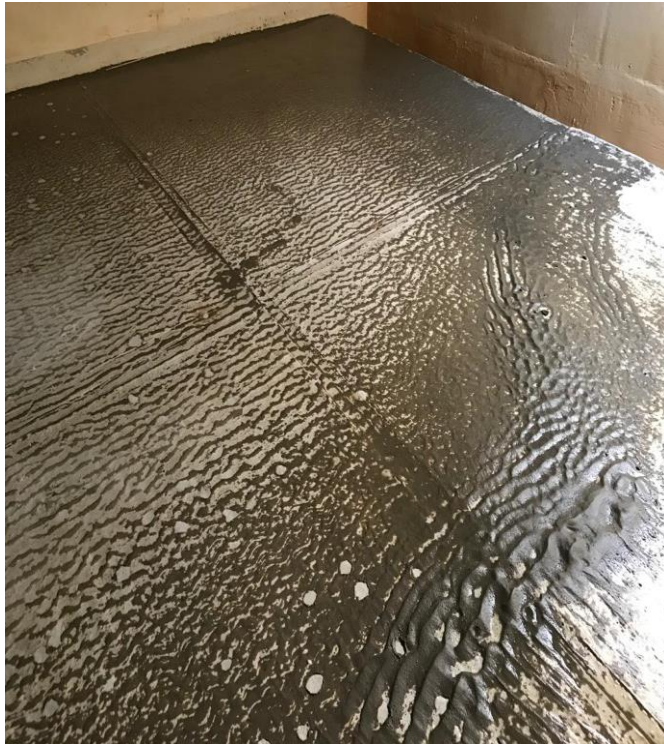
Fondo de Cisterna antes del servicio
