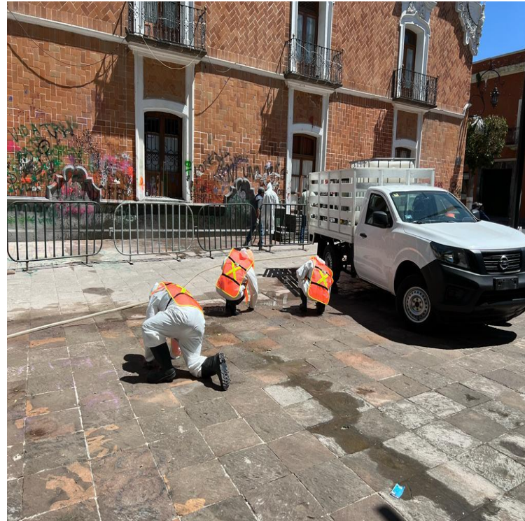
En proceso de limpieza
