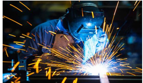
Paileria y soldadura
