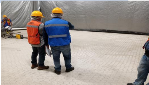
Supervisión de obra
