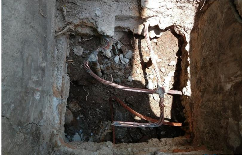
**Instalación de puesta a tierra física, mediante soldadura exotérmica.**
