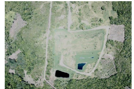
“Proyecto de Clausura y Saneamiento de la Celda Existente en el Relleno Sanitario de Pinoltepec, Emiliano Zapata, Ver.
