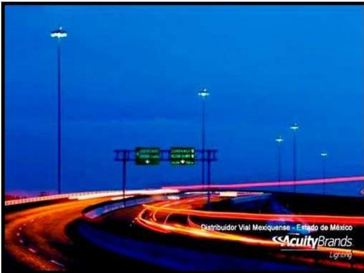
ALUMBRADO DEL CIRCUITO EXTERIOR MEXIQUENSE
