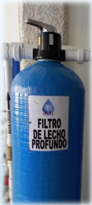
Con éste filtro inicia el tratamiento de agua cruda, el cual contiene grava de diferentes granulaciones para lograr un filtrado con una capacidad de 5 micras a una presión de 150 Psi de trabajo nominal.
