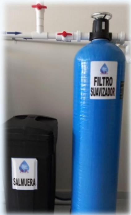
Éste filtro contiene perlas catiónicas, las cuales a través de un intercambio iónico retira del agua las sales minerales así como el Ca y Mg.
