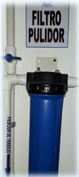
Su función es retener los sólidos suspendidos que pasaron a través de una filtración primaria, es decir pule el filtrado hecho por otro equipo, generalmente un filtro de presión: filtro multimedia.
