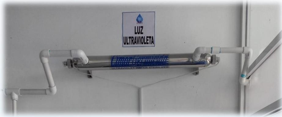
Nuestro sistema de tratamiento y desinfección de **Agua** mediante luz Ultra Violeta (**UV**), garantizan la eliminación de entre el 99,9% y el 99,99 de agentes patógenos. ... Por lo tanto, el **agua** fluye sin detenerse por el interior de los purificadores, que contienen esta **lámpara**.
