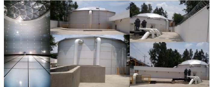
Tanque de Almacenamiento de Agua potable desarrollado para el Gobierno del Estado de Puebla en 2017.
