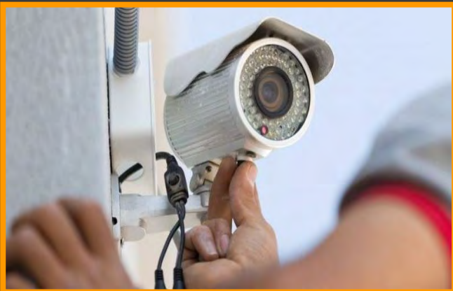
Instalación de cámaras Analógicas, HDCVI e IP
