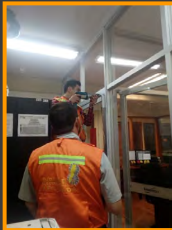
Instalación de control de acceso
