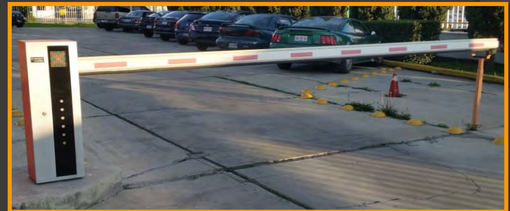
Instalación de control de acceso
