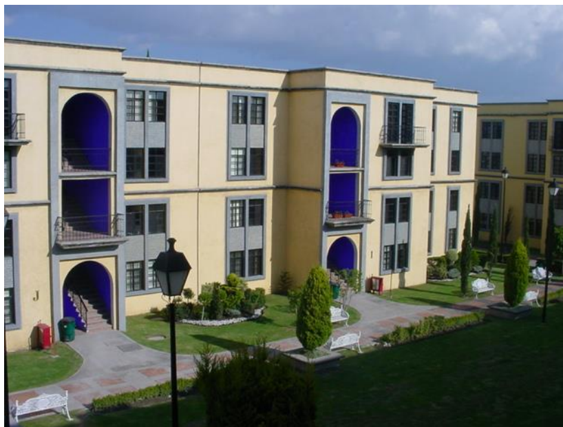
Aplicación de Impermeabilizante y pintura en fachadas e interiores
