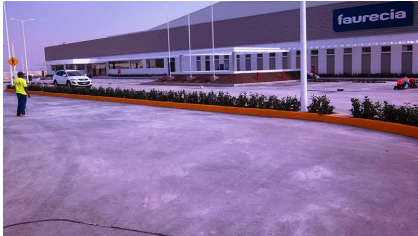
Aplicación de Poliuretanos en interiores de la Nave y señalamiento vial exterior e interior
