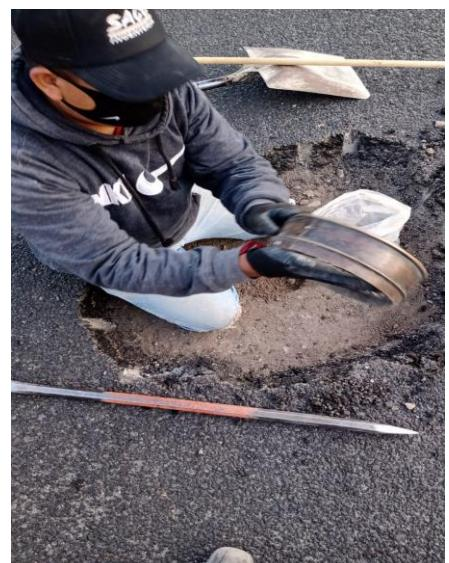
SE OBSERVAN TRABAJOS DE EXTRACCION DE MUESTRAS DEL SUELO Y DE LA ESTRUCTURA DE L PAVIMENTO EXISTENTE
