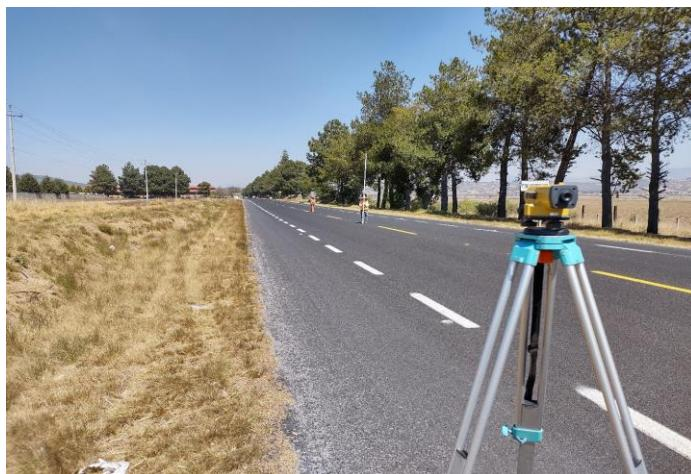
SE OBSERVAN TRABAJOS DE LEVANTAMIENTO TOPOGRAFICO, NIVELACION DEL EJE SOBRE CARRETERA
